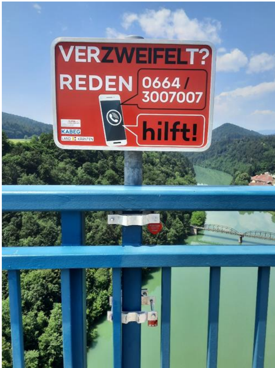
Jörg-Haider Brücke (Lippitzbachbrücke)
